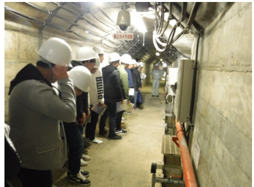
監査廊にて漏水量の測定など説明
