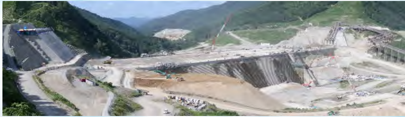
堤体打設状況
