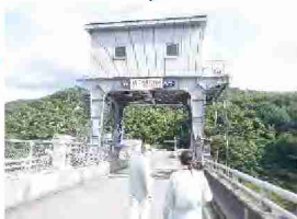
堤体上を動く ガントリークレーン
