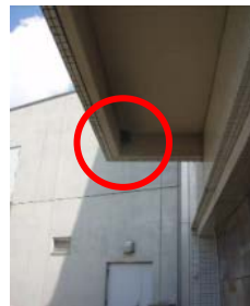
管理用通路脇の屋根の下です
