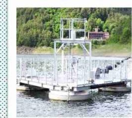
6月1日（火）に、曝気装置の稼働を開始しました。田瀬ダムではアオコの発生抑制のため、平成19年から毎年気温が上がり始めるこの時期に稼働を開始しています。今年度は10月まで稼働予定です。
