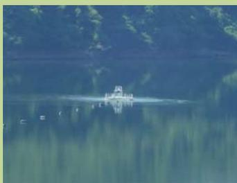
6月1日から曝気装置の運転を開始しました。アオコの発生を抑制するために、毎年6月から10月末まで運転を行っています。田瀬ダムでは、貯水池内に曝気装置を4台設置しています。
