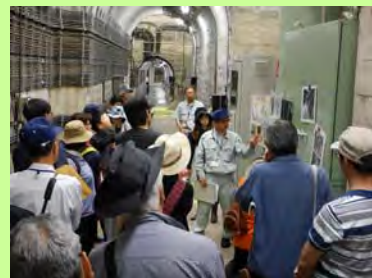
監査廊の様子
