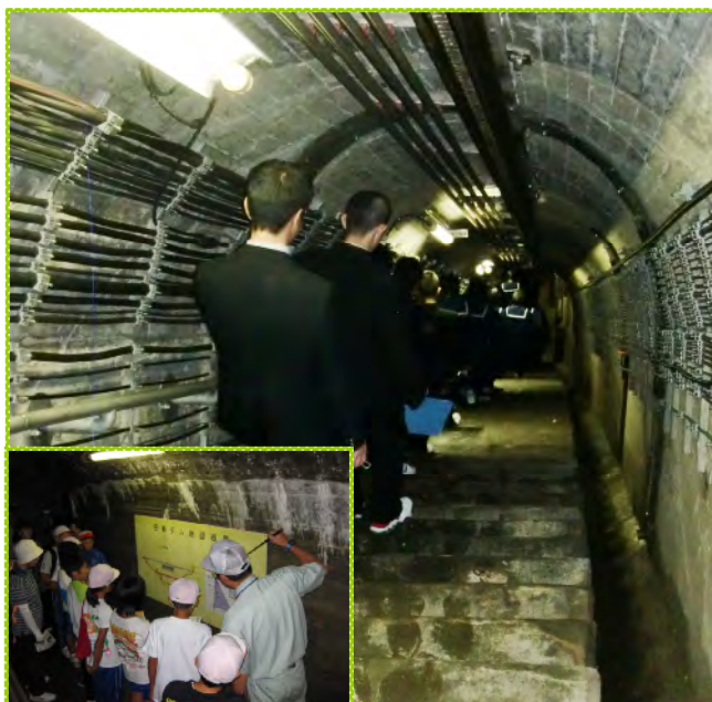
階段を下りて.. ダムの内部を見学!
