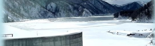
取水塔付近まで結氷した様子(昨年)
