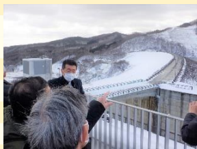
屋上展望デッキからダムを視察
