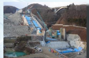
洪水吐きコンクリート打設
