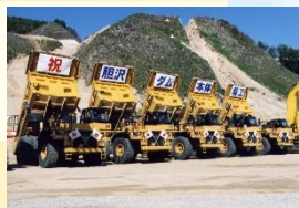
本体工事着手
