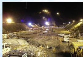
夜間施工状況
