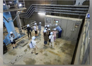
実際に水が流れているゲート(水門)を間近で見学
