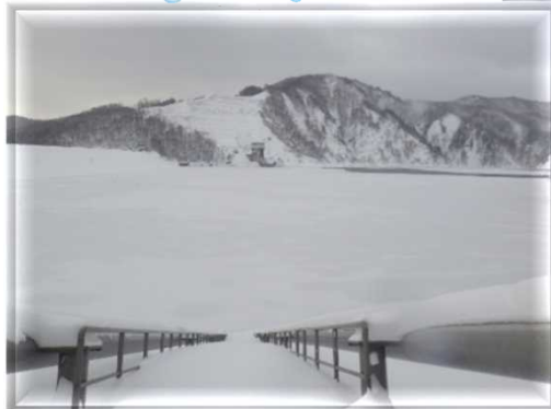
〈係船設備付近〉
