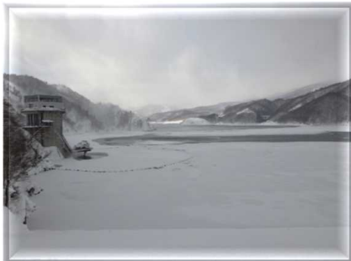
〈取水設備付近〉
