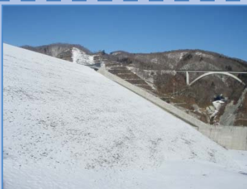
ダム下流から堤体
