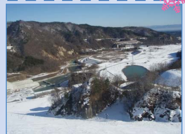
天端からダム下流
