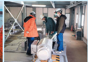
機械設備の状況確認
