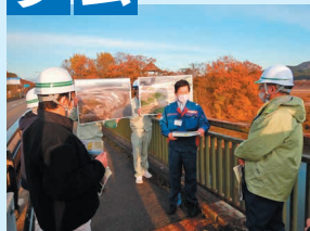
堆砂掘削工事の確認
