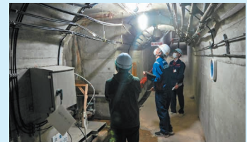
監査廊内の管理設備の状況確認
