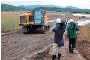
10月5日(水)御所湖内で行っている堆積土砂掘削工事を報道関係機関に公開しました。洪水などで大量の土砂が堆積すると、貯水容量が減少し治水・利水機能の低下につながります。こうした状況を防止するために土砂の撤去工事を行っています。
