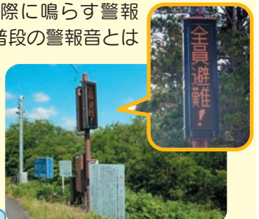
令和3年度ダム警報訓練の様子
