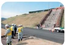
御所ダム管理所構内
