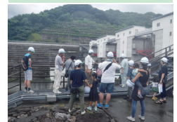
間近に見る放流ゲート
