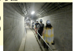
ダム内部の階段をぐんぐん下ります。
