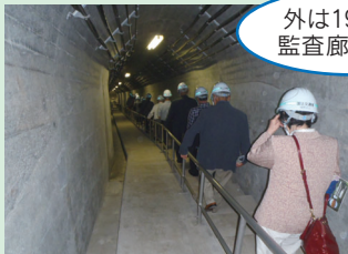
階段を下り、監査廊最深部へ向かいます
