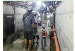
ダム内部(監査廊)最深部に到着
