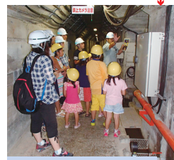
ダム内部(監査廊)
