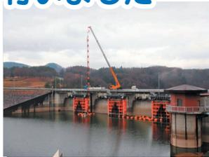
堤体からクレーンを使って、網場を貯水池に下ろします
