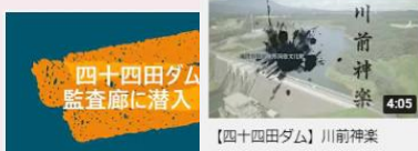
【四十四田ダム】監査廊に潜入!
