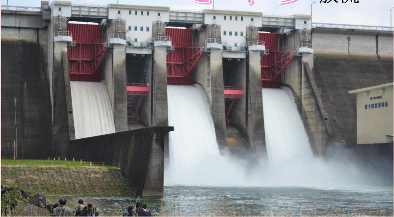
4月23日（土）、本格的な出水期を迎える前に、ダム最上部にあるクレストゲートが正常に作動するかを確認するための点検放流（さくら放流）を行いました。
