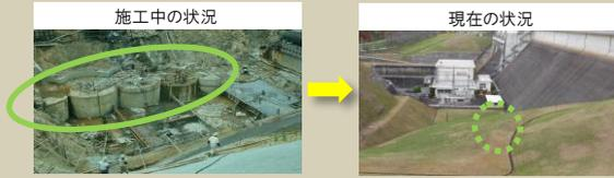
四十四田ダムの中央部は重力式コンクリートダムですが、一部に弱い岩盤があったため、直径15mのコンクリートの円柱6本からなるレジスティングブロックを岩盤の中に造り、その上にコンクリートダムを建設しています。ダムの下なので現在は見る事が出来ませんが、ダムを支える「縁の下の力持ち」です。
