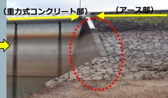
四十四田ダムは、中央部分が重力式コンクリートダム、両袖をアースダムとする複合型式となっていますが、複合ダムは接合部が弱くなりやすいことから、その部分からの水漏れがないよう、いろいろな工夫を行っています。例えば、接合部のコンクリート面(セパレートウォール)に勾配を持たせることで、地震などでアース内に隙間が出来ても、アースの重みで密着するようにしています。
