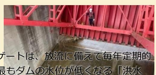
放流設備（ゲート）の点検を行いました。ダムのゲートは、放流に備えて毎年定期的に点検整備を行っており、点検の時期は一年の中で最もダムの水位が低くなる「洪水期」とよばれる7月～9月の間に実施されます。
