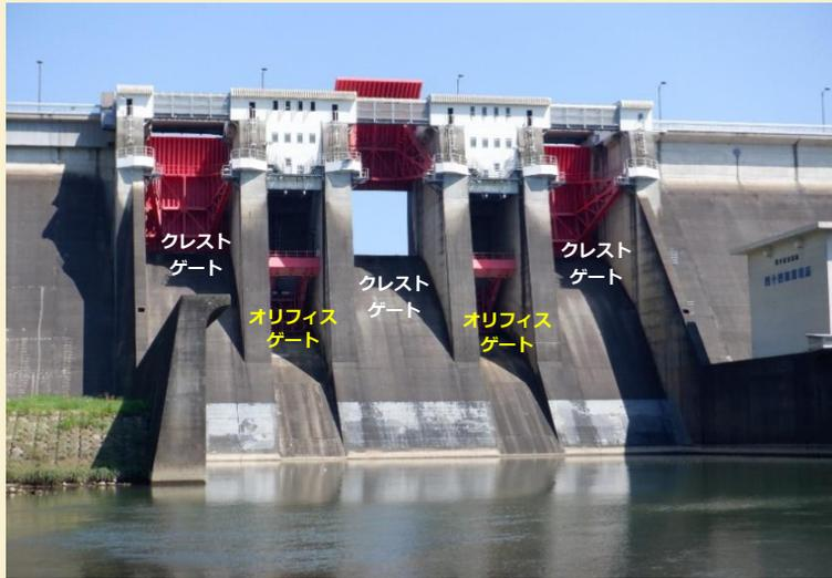
8月19日(水)に四十四田ダムでクレストゲートの点検を行いました。ダムのゲートは、放流に備えて毎年定期的に保守点検を行っており、点検の時期は一年の中で最もダムの水位が低くなる「洪水期」とよばれる7月～9月の間に実施されます。
