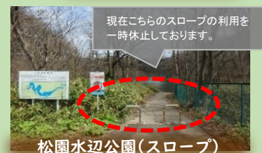
危険箇所点検中
