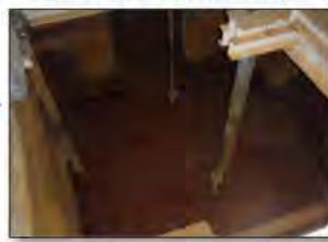
中和槽 (バクテリアと炭酸カルシウム溶液を添加し中和)
