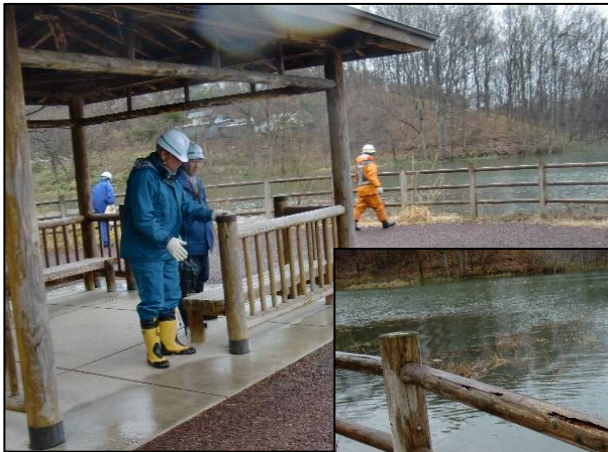
点検中の様子
