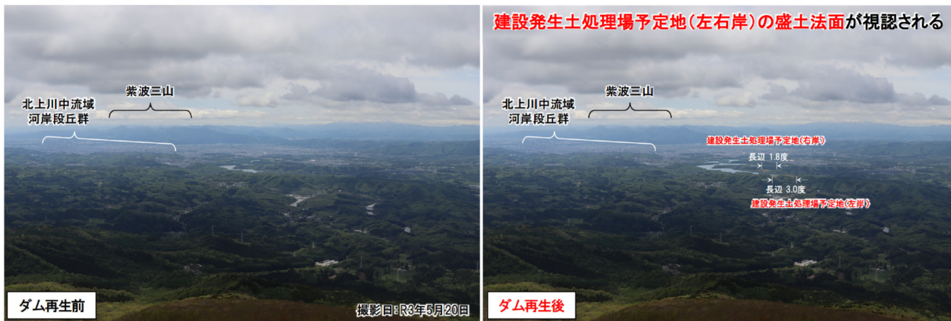
図8-3 姫神山からの眺望景観の変化 (ダム再生前後)
