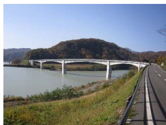
栗駒焼石ホットライン奥州湖大橋
