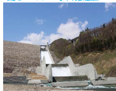
※②庄巻の融雪放流（武兵衛穴出口より）
