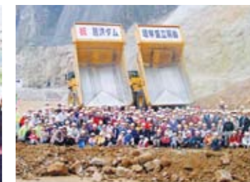
【写真4】堤体盛立開始
