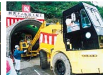
【写真2】転流工事着手
