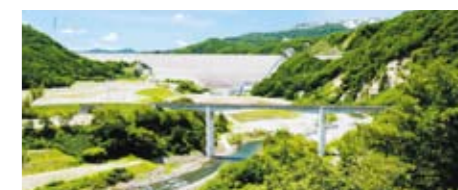
下流から胆沢ダムを望む
