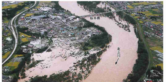
▲ 平成19年9月洪水 水沢工業団地の浸水状況
