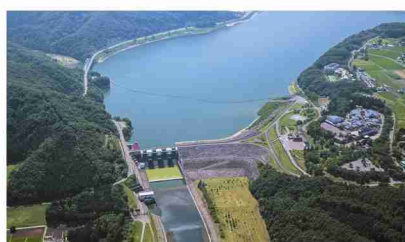
▲ 御所ダム (昭和56年竣工)
