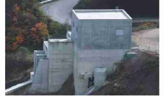
▼利水放流ゲート室
