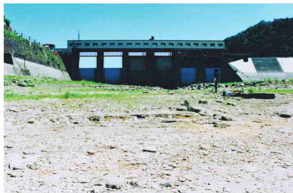
▲ 干上がった石淵ダム（平成6年渇水）
