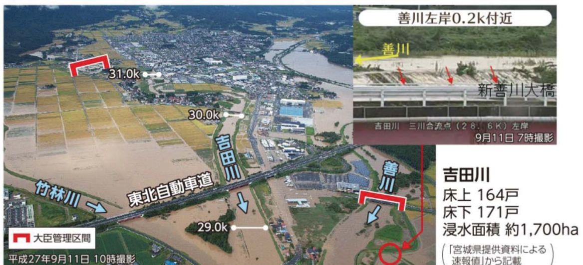
平成27年9月11日出水状況(29.0km付近:吉田川上流地区付近)
