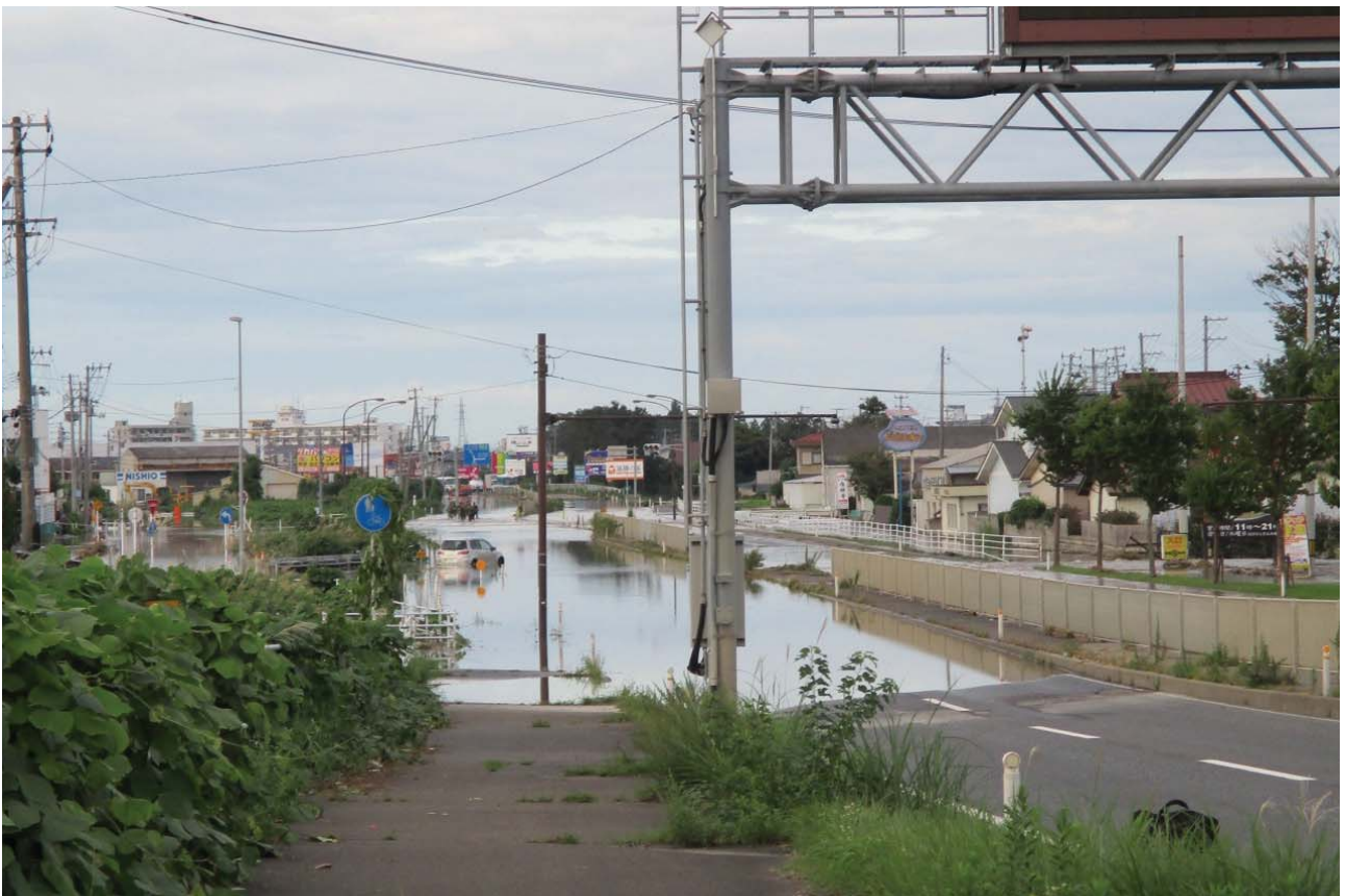
■ 国道4号線冠水状況・大崎市古川米袋地内 (9月11日 16:30 撮影)
