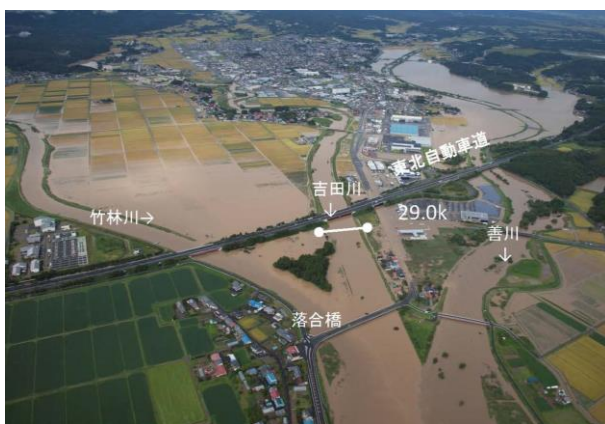
【吉田川上流部三川合流点付近の越水、溢水状況】
