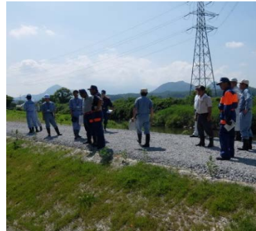
▲竹林川右岸3.0k(三ノ堰馬場)重要水防箇所の巡視
