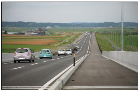
二線堤整備状況
