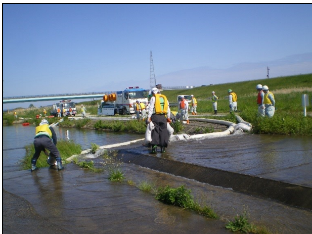
排水ポンプ車による排水作業
