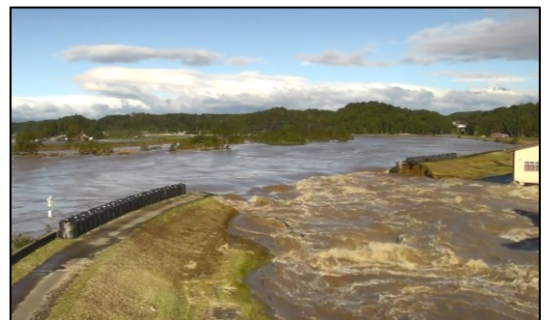
吉田川左岸の堤防決壊（大郷町粕川）
