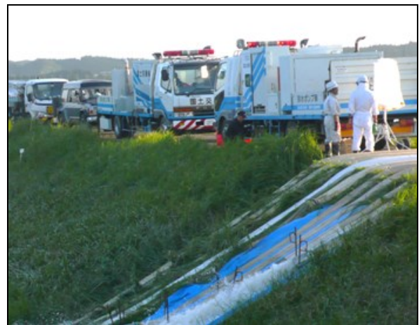
排水ポンプ車設置訓練状況
