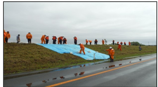
江合川での水防活動（シート張り）
