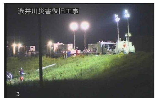
照明車設置による24時間復旧工事
