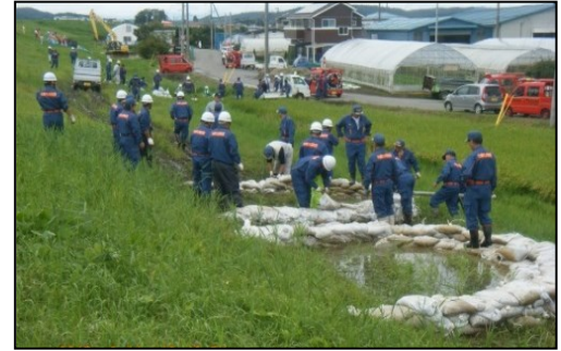
吉田川での水防活動（月の輪工）
