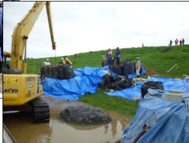
建設業者の重機を活用した月の輪工による漏水対策を実施 (大崎市鹿島台大迫上志田地内)
