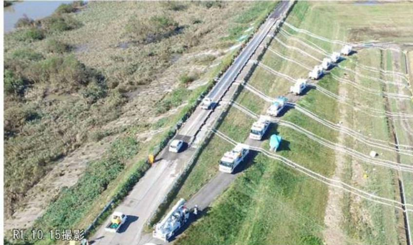
図 7-8 令和元年台風第19号の排水作業の様子
