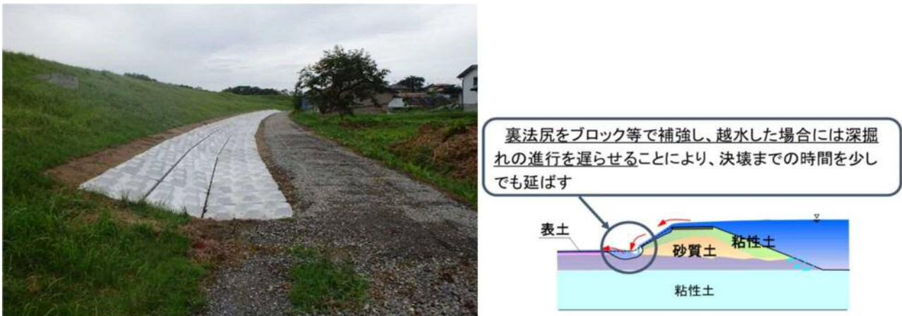
図 7-4 堤防裏法尻の補強イメージ
