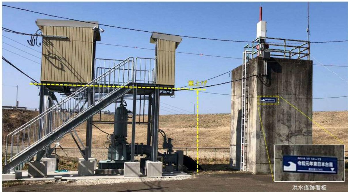
図 7-22 排水機場操作盤嵩上げ（後谷地排水機場）
