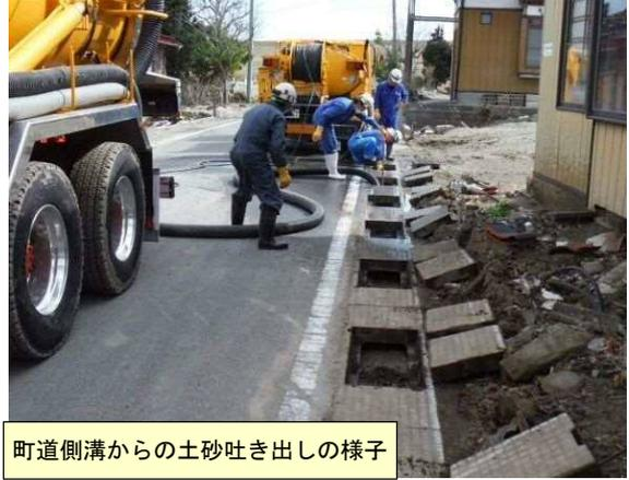
町道側溝からの土砂吐き出しの様子
