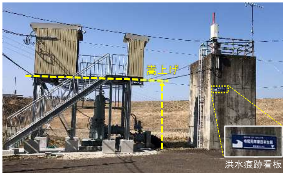
排水機場操作盤嵩上げ（後谷地排水機場）
