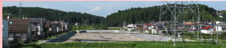
雨水貯留施設・調整池の整備（巳待田調整池）
