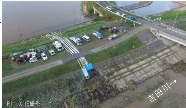
大郷大橋（18K）左岸の側帯部分を活用した排水作業の様子。応急復旧用の資材置き場、災害対策車の待機所等にも活用された。
