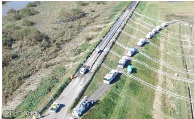
令和元年10月洪水では、ホースブリッジにより一般車両の通行を確保しつつ、排水作業を実施した。
