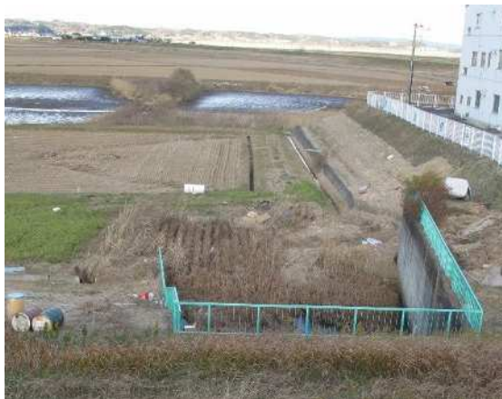
志田谷地排水樋管の法裏部
