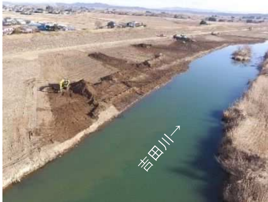
河道掘削イメージ
