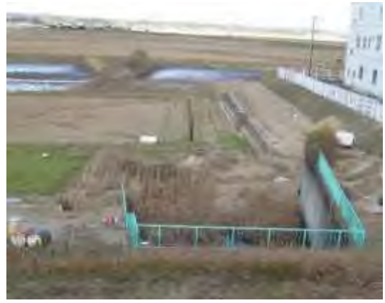
志田谷地排水樋門の法裏部 排水敷高の工夫等により、排水能力向上を図る
