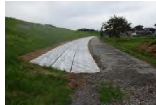
堤防裏法尻の補強
