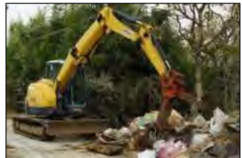
道路啓開作業の様子
