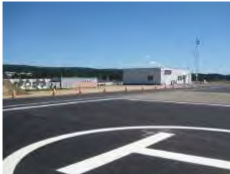
涌谷地区河川防災ステーション
