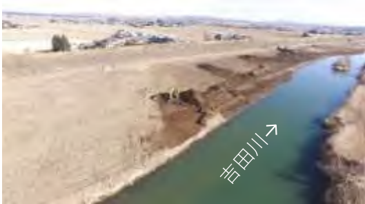
河道掘削イメージ
