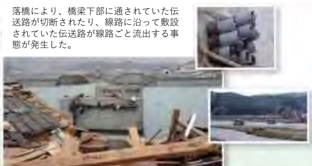
気仙大橋 (国道45号) が流出し、橋梁下部に設置されていた中継伝送路が切断 (岩手県陸前高田市)
