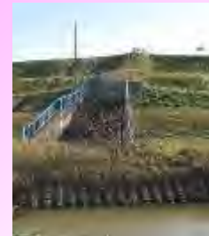
内浦緊急排水樋門（呑口部）
