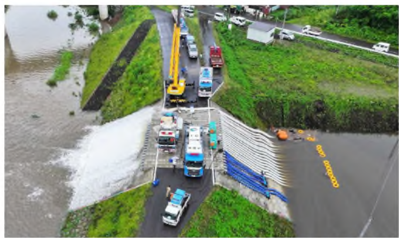
大仙市排水ポンプ車活動状況（7月19日）
