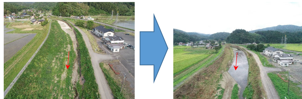
河道掘削（堆積土砂撤去）：鱒淵川
