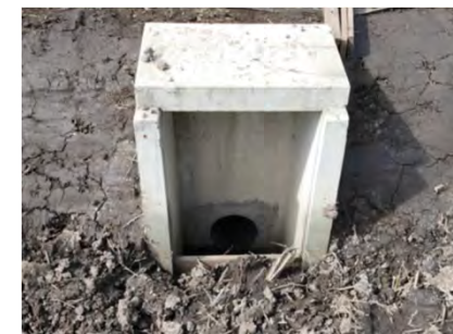
落水口の整備
