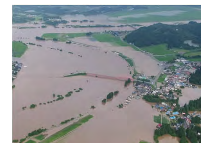
本川からの浸水状況
