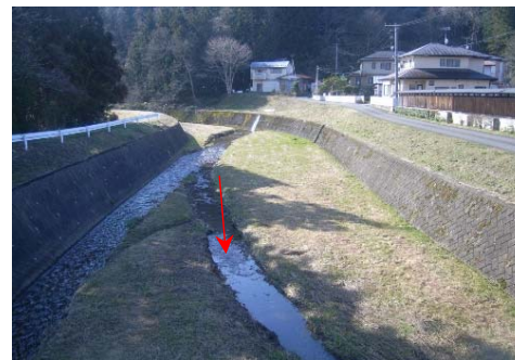
河道掘削（堆積土砂撤去）：熊谷川
