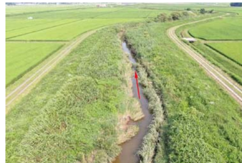
河道掘削（堆積土砂撤去）：熊谷川
