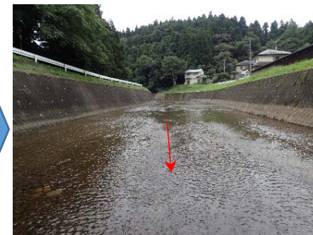
河道掘削（堆積土砂撤去）：蛭沢川
