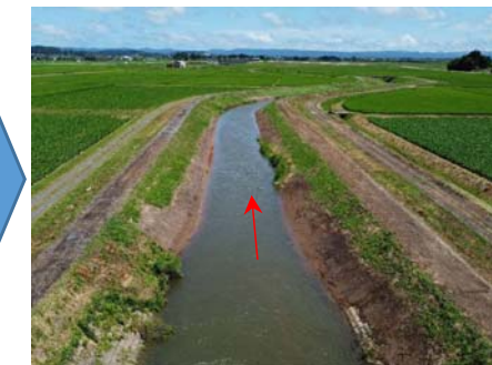
河道掘削（堆積土砂撤去）：熊谷川
