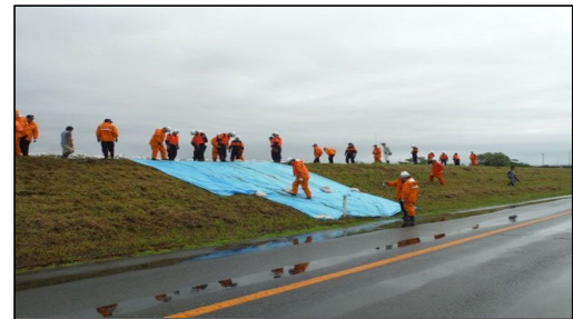
江合川での水防活動（シート張工）
