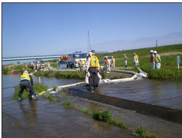
排水ポンプ車による排水作業
