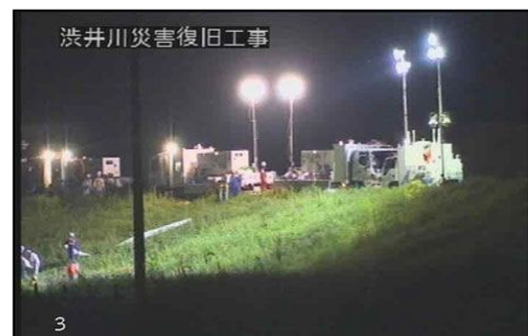
照明車設置による24時間復旧工事
