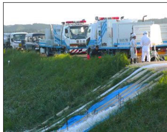
排水ポンプ車設置訓練状況
