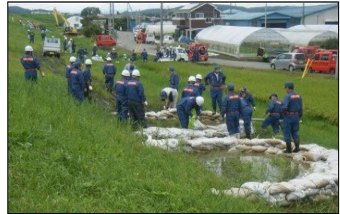
吉田川での水防活動（月の輪工）
