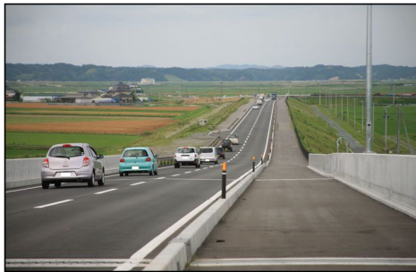
二線堤整備状況
