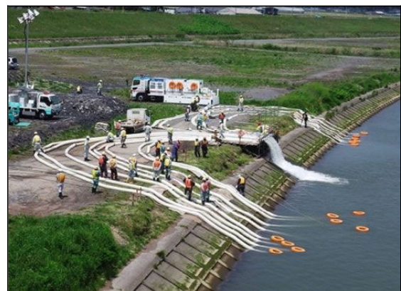
排水ポンプ車設置訓練状況
