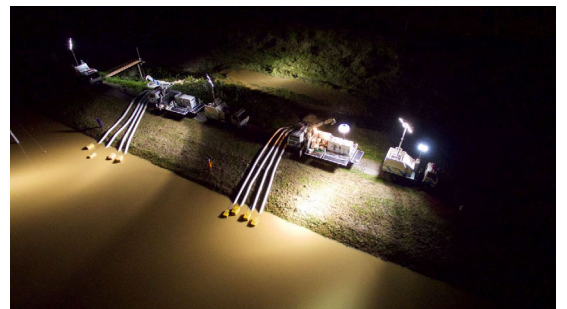
二迫川排水状況（H27.9洪水）
