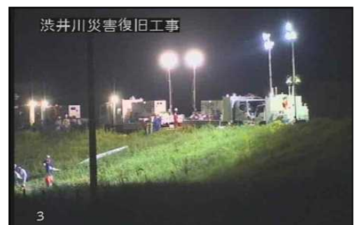
照明車設置による24時間復旧工事
