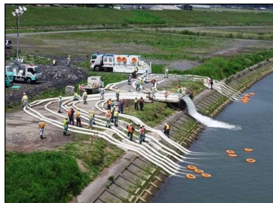
排水ポンプ車設置訓練状況
