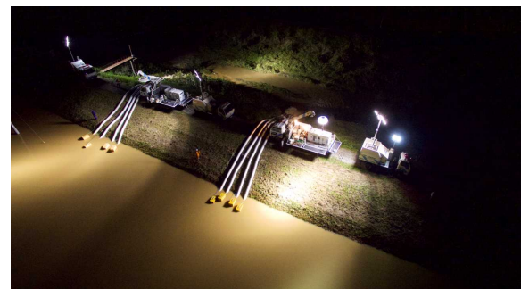
二迫川排水状況（H27.9洪水）
