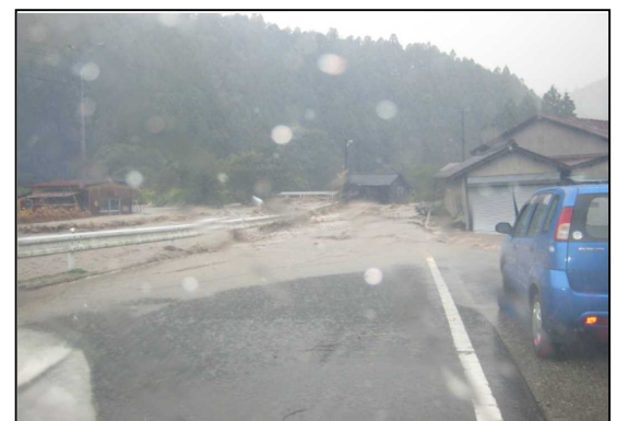
平成21年10月洪水で越水した南沢川
