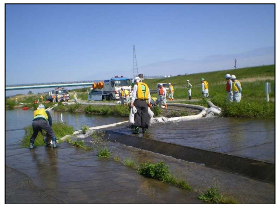
排水ポンプ車設置訓練状況
