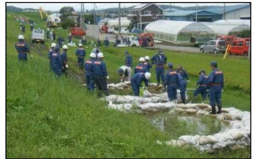
吉田川での水防活動（月の輪工）
