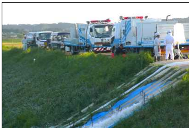
排水ポンプ車による排水作業
