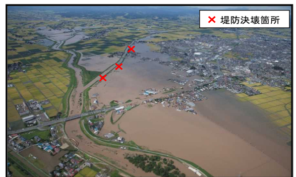
平成27年9月関東・東北豪雨で 3箇所堤防が決壊した洪井川
