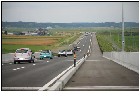
二線堤整備状況
