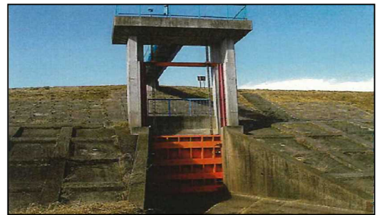
非常用排水樋管（内浦排水樋管）
