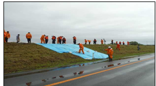
江合川での水防活動（シート張り）
