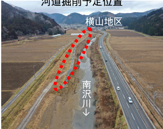
河道掘削イメージ
