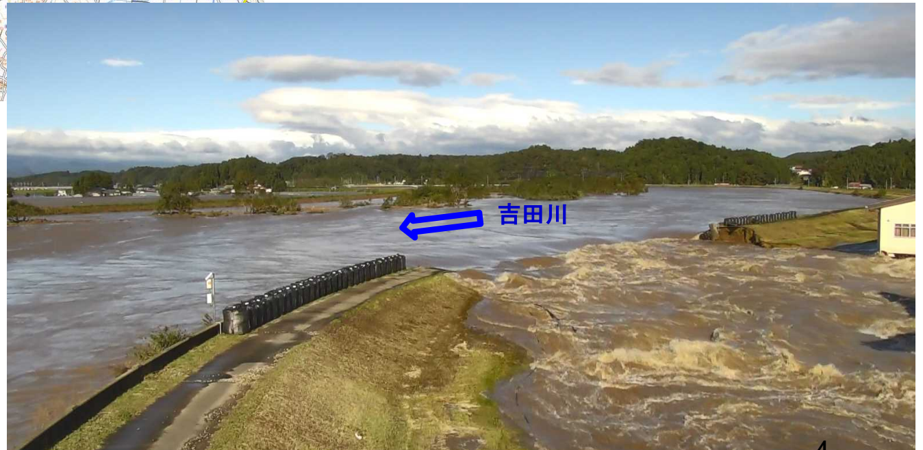
【吉田川左岸20.9k 堤防決壊箇所】
