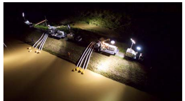
二迫川排水状況（H27.9洪水）
