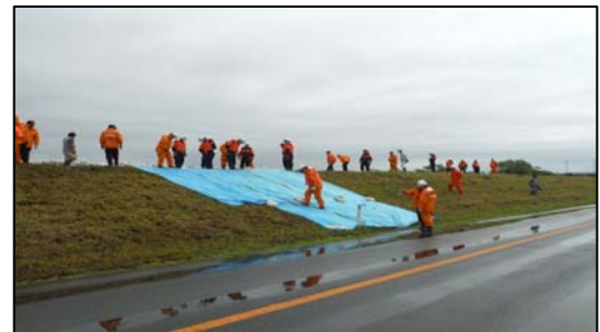
江合川での水防活動（シート張工）
