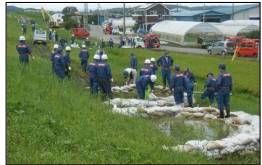
吉田川での水防活動（月の輪工）
