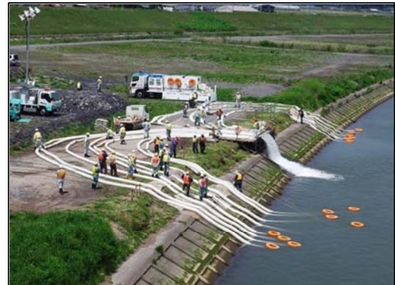
排水ポンプ車設置訓練状況
