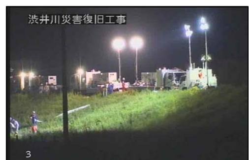
照明車設置による24時間復旧工事
