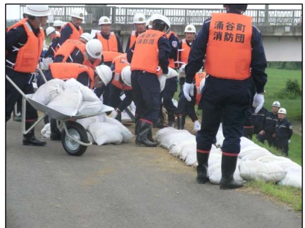
合同水防訓練（涌谷町・美里町）
