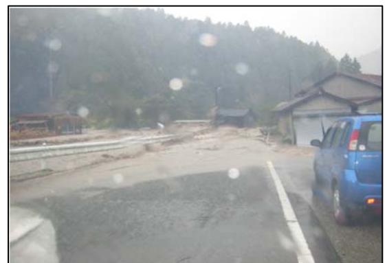
平成21年10月洪水で越水した南沢川
