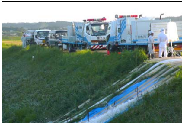
排水ポンプ車による排水作業
