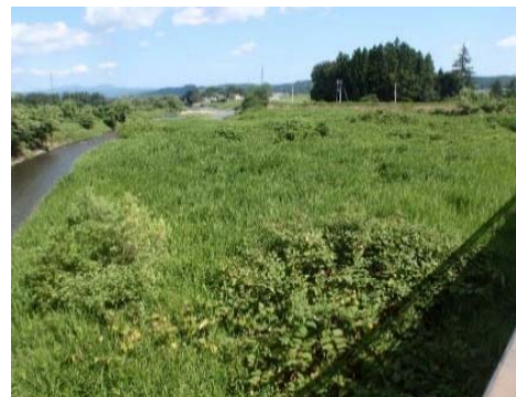
河道掘削 田川（加美町）
