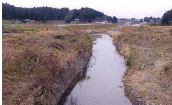
河川改修 味明川（大郷町）
