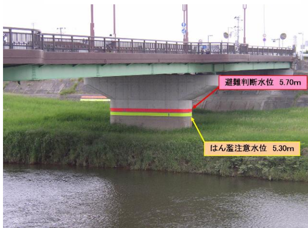
避難氾濫水位等を現地の橋脚等へ表示
