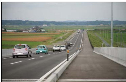
二線堤整備状況
