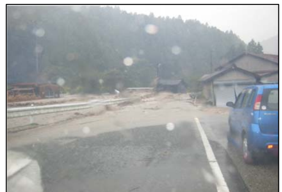
平成21年10月洪水で越水した南沢川
