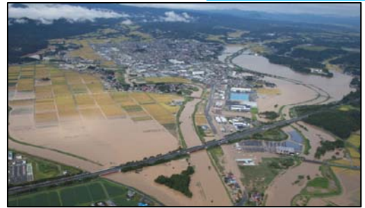
平成27年9月関東・東北豪雨で 浸水した大和町中心部
