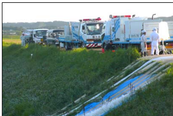
排水ポンプ車による排水作業
