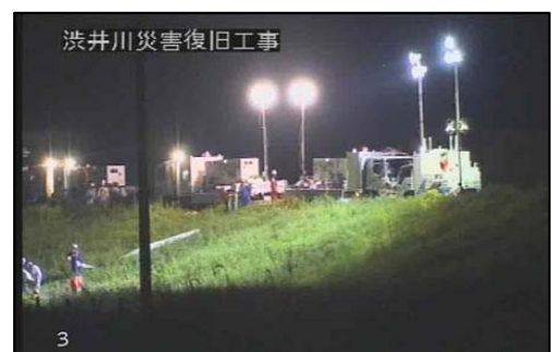
照明車設置による24時間復旧工事
