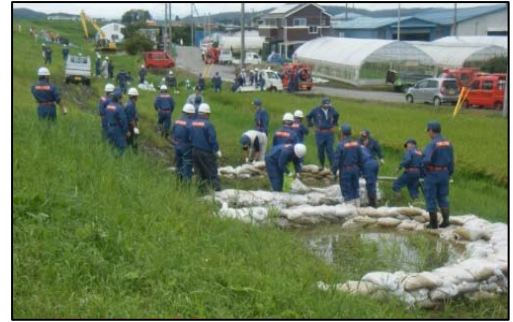
吉田川での水防活動（月の輪工）
